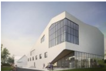
• 2017-06-29-Rozpoczęcie budowy budynku teatru Rabcio
