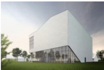
• 2017-06-29-Rozpoczęcie budowy budynku teatru Rabcio
