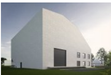
• 2017-06-29-Rozpoczęcie budowy budynku teatru Rabcio
