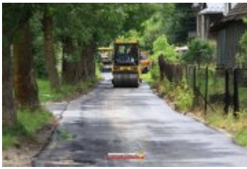
• 2017-06-30-Nowa nawierzchnia na Alei Tysiąclecia
