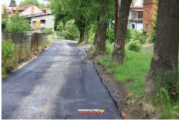
• 2017-06-30-Nowa nawierzchnia na Alei Tysiąclecia
