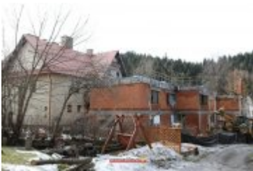
• 2017-02-24-Budowa sali gimnastycznej w Ponicach
