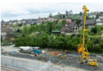
• 2024-04-17-Palowanie osuwiska na ul. Zakopiańskiej
