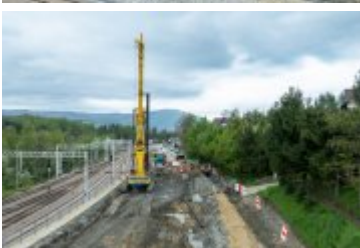
• 2024-04-17-Palowanie osuwiska na ul. Zakopiańskiej
