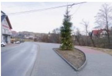
• 2024-01-05-Budowa parkingu obok remizy OSP w Rdzawce
