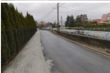
• 2024-01-03-Remont ulicy Bystrej
