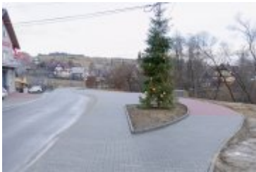
• 2024-01-05-Budowa parkingu obok remizy OSP w Rdzawce
