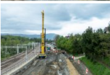
• 2024-04-17-Palowanie osuwiska na ul. Zakopiańskiej
