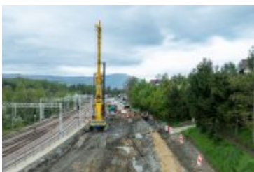
• 2024-04-17-Palowanie osuwiska na ul. Zakopiańskiej
