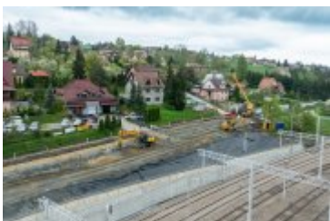
• 2024-04-17-Palowanie osuwiska na ul. Zakopiańskiej
