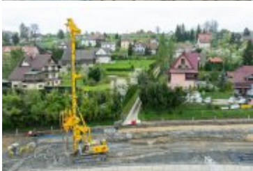
• 2024-04-17-Palowanie osuwiska na ul. Zakopiańskiej
