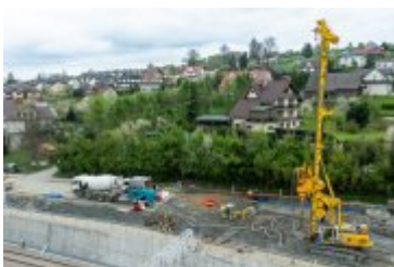
• 2024-04-17-Palowanie osuwiska na ul. Zakopiańskiej
