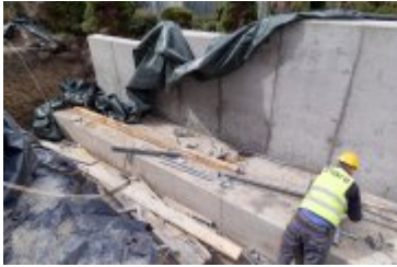
• 2024-03-28-Postępy prac na budowie szpitala
