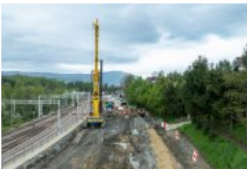
• 2024-04-17-Palowanie osuwiska na ul. Zakopiańskiej
