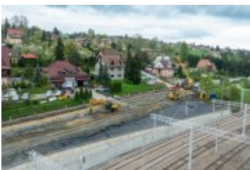
• 2024-04-17-Palowanie osuwiska na ul. Zakopiańskiej
