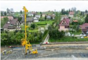
• 2024-04-17-Palowanie osuwiska na ul. Zakopiańskiej
