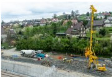
• 2024-04-17-Palowanie osuwiska na ul. Zakopiańskiej
