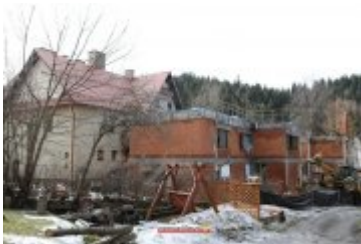
• 2017-02-24-Budowa sali gimnastycznej w Ponicach
