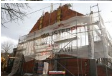
• 2017-02-24-Budowa sali gimnastycznej w Ponicach
