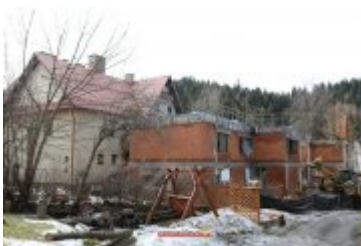
• 2017-02-24-Budowa sali gimnastycznej w Ponicach
