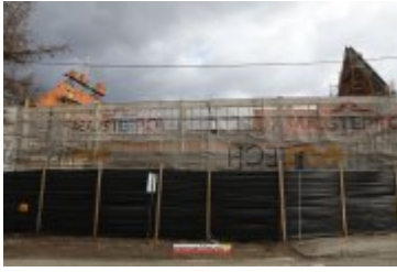
• 2017-02-24-Budowa sali gimnastycznej w Ponicach
