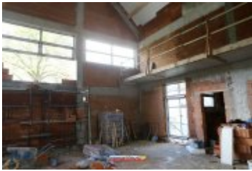
• 2017-05-09-Budowa sali gimnastycznej w Ponicach
