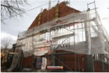
• 2017-02-24-Budowa sali gimnastycznej w Ponicach
