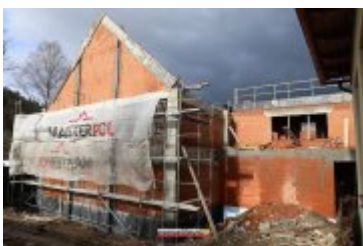
2017-02-24-Budowa sali gimnastycznej w Ponicach
