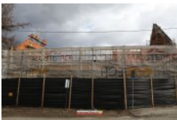
2017-02-24-Budowa sali gimnastycznej w Ponicach
