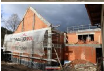
2017-02-24-Budowa sali gimnastycznej w Ponicach
