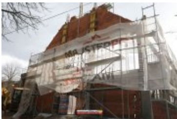
• 2017-02-24-Budowa sali gimnastycznej w Ponicach
