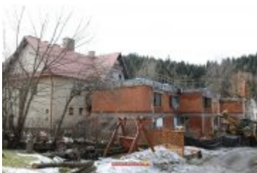
• 2017-02-24-Budowa sali gimnastycznej w Ponicach
