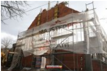
• 2017-02-24-Budowa sali gimnastycznej w Ponicach
