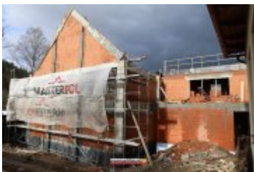
2017-02-24-Budowa sali gimnastycznej w Ponicach
