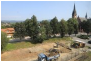
• 2019-08-27-Budowa parkingu przy Teatrze Rabcio
