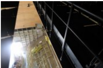
• 2019-08-27-Budowa parkingu przy Teatrze Rabcio
