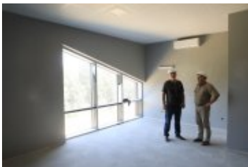
• 2019-08-27-Budowa parkingu przy Teatrze Rabcio
