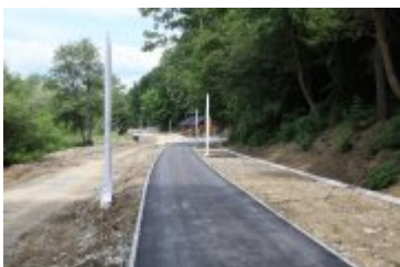
• 2019-06-24-Postępy prac na budowie bulwarów nad Poniczanką
