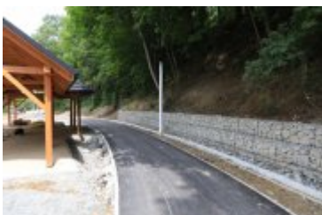
• 2019-06-24-Postępy prac na budowie bulwarów nad Poniczanką
