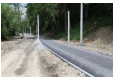
• 2019-06-24-Postępy prac na budowie bulwarów nad Poniczanką
