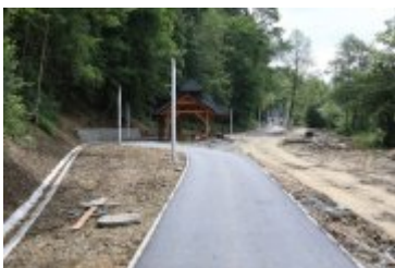
• 2019-06-24-Postępy prac na budowie bulwarów nad Poniczanką
