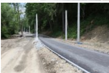
• 2019-06-24-Postępy prac na budowie bulwarów nad Poniczanką
