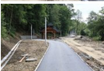
• 2019-06-24-Postępy prac na budowie bulwarów nad Poniczanką
