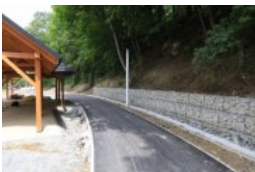
• 2019-06-24-Postępy prac na budowie bulwarów nad Poniczanką
