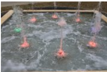
• 2019-09-02-Odbiory techniczne bulwarów nad Poniczanką
