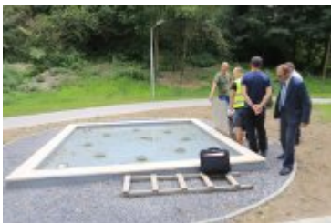
• 2019-09-02-Odbiory techniczne bulwarów nad Poniczanką
