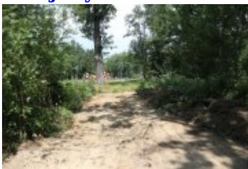
• 2019-08-07-Rozpoczęcie budowy wodnego placu zabaw w Parku Zdrojowym
