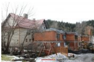
• 2017-02-24-Budowa sali gimnastycznej w Ponicach
