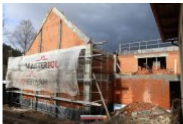
• 2017-02-24-Budowa sali gimnastycznej w Ponicach
