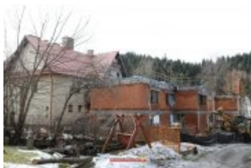
• 2017-02-24-Budowa sali gimnastycznej w Ponicach
