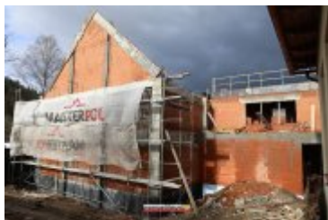
2017-02-24-Budowa sali gimnastycznej w Ponicach
