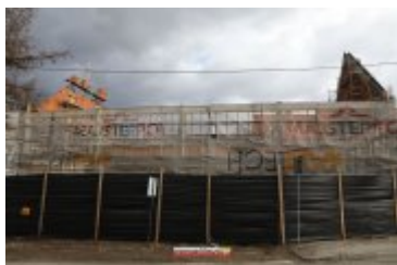
2017-02-24-Budowa sali gimnastycznej w Ponicach
