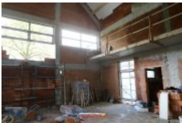
• 2017-05-09-Budowa sali gimnastycznej w Ponicach
