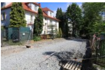
• 2022-06-17-Remont ulicy Brzozowej
