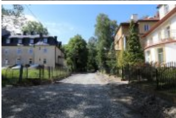
• 2022-06-17-Remont ulicy Brzozowej
