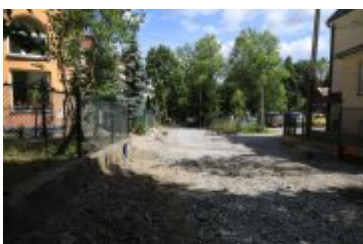
• 2022-06-17-Remont ulicy Brzozowej
