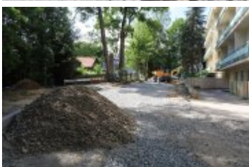
• 2022-06-17-Remont ulicy Brzozowej
