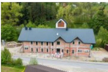
• 2022-05-18-Budowa remizy OSP w Ponicach
