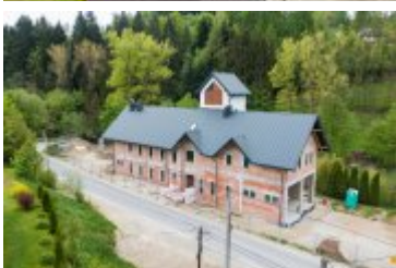
• 2022-05-18-Budowa remizy OSP w Ponicach
