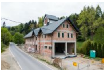
• 2022-05-18-Budowa remizy OSP w Ponicach
