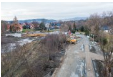
• 2021-12-01-Postępy prac na budowie mostu na Poniczance
