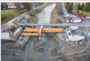
• 2021-12-01-Postępy prac na budowie mostu na Poniczance
