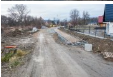
• 2021-12-01-Postępy prac na budowie mostu na Poniczance
