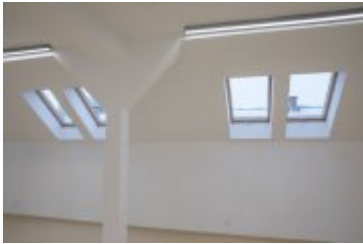
• 2021-12-07-Adaptacja pomieszczeń poddasza nieużytkowego w budynku SP nr 3 na salę wielofunkcyjną
