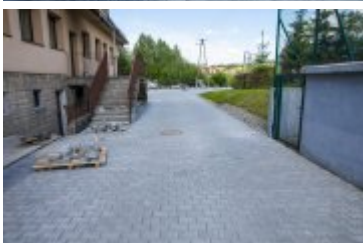
• 2021-06-04-Budowa placu zabaw w Rdzawce
