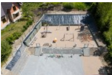
• 2021-06-04-Budowa placu zabaw w Rdzawce
