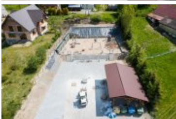
• 2021-06-04-Budowa placu zabaw w Rdzawce
