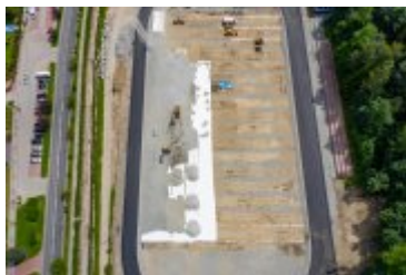
• 2020-07-16-Przebudowa Stadionu Miejskiego
