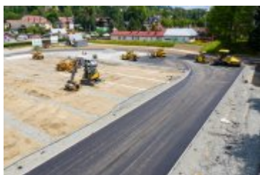
• 2020-07-16-Przebudowa Stadionu Miejskiego
