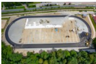
• 2020-07-16-Przebudowa Stadionu Miejskiego
