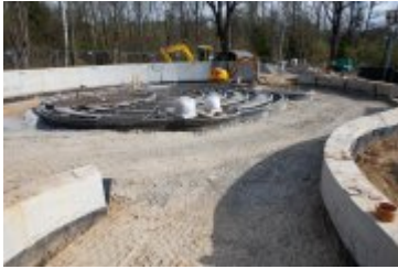
• 2020-04-24-Postępy prac przy budowie wodnego placu zabaw
