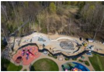
• 2020-04-24-Postępy prac przy budowie wodnego placu zabaw
