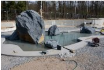
• 2020-04-24-Postępy prac przy budowie wodnego placu zabaw
