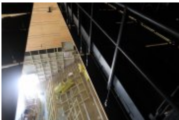
• 2019-08-27-Budowa parkingu przy Teatrze Rabcio
