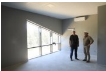
• 2019-08-27-Budowa parkingu przy Teatrze Rabcio
