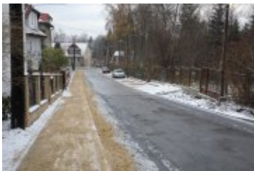
• 2018-11-29-Zakończenie remontu ulicy Cichej
