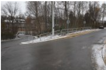
• 2018-11-29-Zakończenie remontu ulicy Cichej
