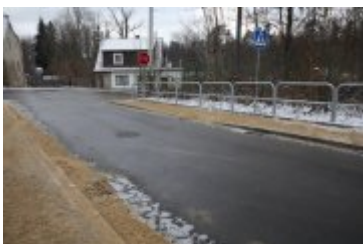
• 2018-11-29-Zakończenie remontu ulicy Cichej
