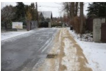
• 2018-11-29-Zakończenie remontu ulicy Cichej
