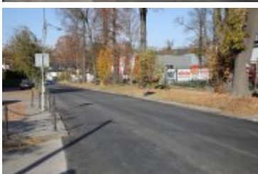
• 2018-10-16-Zakończenie remontu ulicy Podhalańskiej
