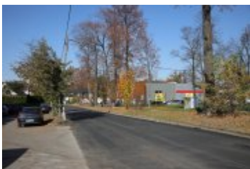
• 2018-10-16-Zakończenie remontu ulicy Podhalańskiej
