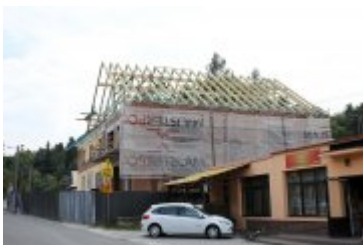
• 2018-08-09-Rozbudowa remizy OSP w Rdzawce
