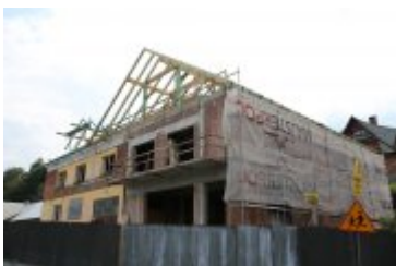
2018-08-09-Rozbudowa remizy OSP w Rdzawce
