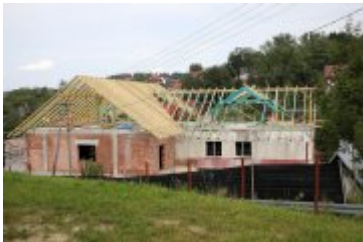
• 2018-08-09-Rozbudowa remizy OSP w Rdzawce
