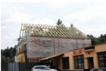
2018-08-09-Rozbudowa remizy OSP w Rdzawce
