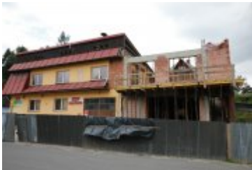
2018-07-03-Rozbudowa remizy OSP w Rdzawce
