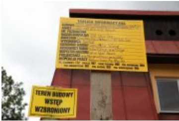
2018-07-03-Rozbudowa remizy OSP w Rdzawce
