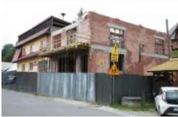
2018-07-03-Rozbudowa remizy OSP w Rdzawce
