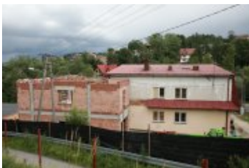
2018-07-03-Rozbudowa remizy OSP w Rdzawce
