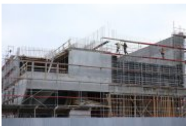
• 2018-02-21-Budowa nowego budynku Teatru Lalek Rabcio
