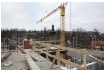
• 2018-02-21-Budowa nowego budynku Teatru Lalek Rabcio
