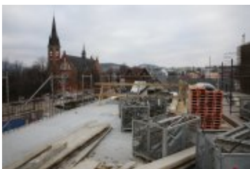
• 2018-02-21-Budowa nowego budynku Teatru Lalek Rabcio
