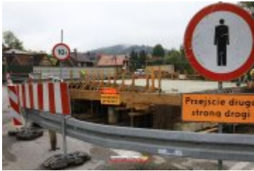
• 2017-09-20-Budowa mostu na Poniczance w Ponicach
