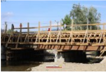
• 2017-09-20-Budowa mostu na Poniczance w Ponicach
