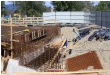
• 2017-09-20-Budowa mostu na Poniczance w Ponicach
