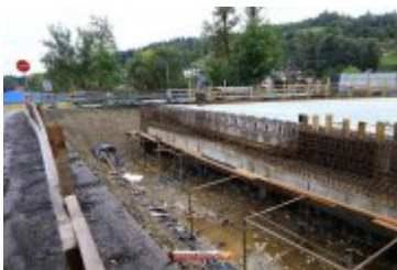
• 2017-09-20-Budowa mostu na Poniczance w Ponicach
