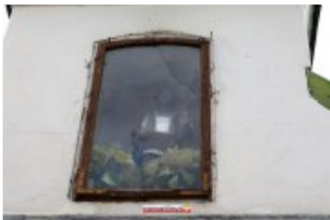
• 2017-09-12-Remont kapliczki św. Floriana przy ul. Sąddeckiej
