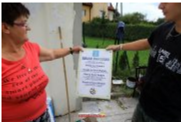
• 2017-09-12-Remont kapliczki św. Floriana przy ul. Sąddeckiej
