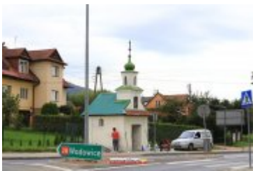
• 2017-09-12-Remont kapliczki św. Floriana przy ul. Sąddeckiej
