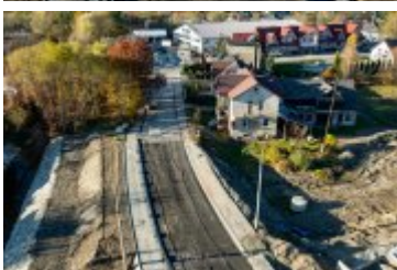
• 2024-10-25- Nowa nawierzchnia na ul. Jana Pawła II
