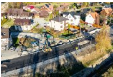
• 2024-10-25- Nowa nawierzchnia na ul. Jana Pawła II
