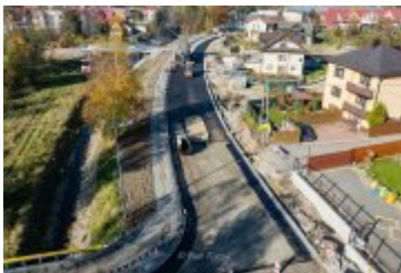
• 2024-10-25- Nowa nawierzchnia na ul. Jana Pawła II
