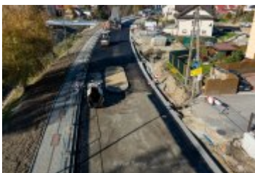
• 2024-10-25- Nowa nawierzchnia na ul. Jana Pawła II
