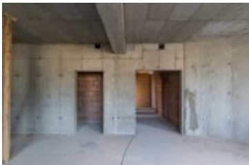
• 2024-08-22- Postępy prac na budowie szpitala
