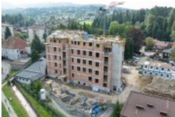
• 2024-08-22- Postępy prac na budowie szpitala
