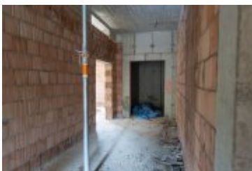
• 2024-08-22- Postępy prac na budowie szpitala
