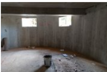
• 2024-08-22- Postępy prac na budowie szpitala
