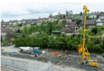
• 2024-04-17-Palowanie osuwiska na ul. Zakopiańskiej
