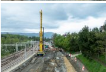
• 2024-04-17-Palowanie osuwiska na ul. Zakopiańskiej
