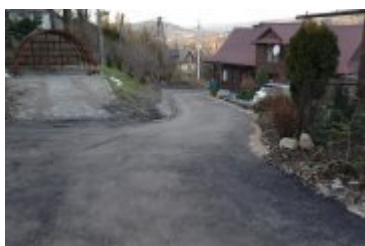
• 2023-12-28-Remont ulicy Wójtowiczowa
