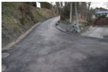
• 2023-12-28-Remont ulicy Wójtowiczowa
