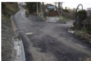
• 2023-12-28-Remont ulicy Wójtowiczowa
