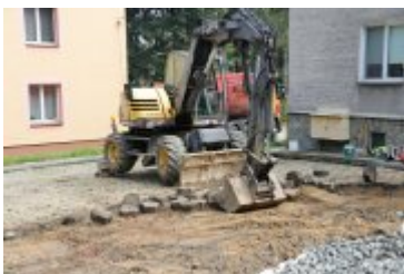
• 2023-08-22-Przebudowa drogi osiedlowej przy ul. Chopina
