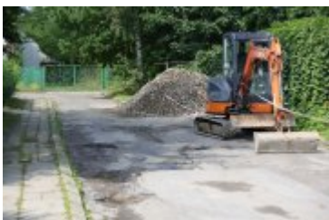
• 2023-08-22-Przebudowa drogi osiedlowej przy ul. Chopina
