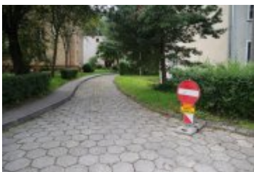
• 2023-08-22-Przebudowa drogi osiedlowej przy ul. Chopina
