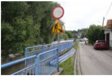
• 2023-08-10-Remont ulicy Bystrej
