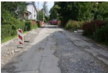
• 2023-08-09-Remont ulicy Słowackiego
