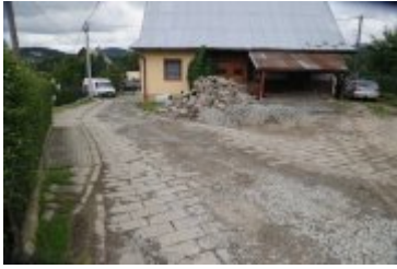
• 2023-08-10-Remont ulicy Bystrej
