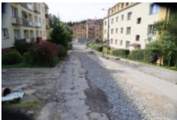
• 2023-08-09-Remont ulicy Słowackiego
