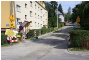
• 2023-08-09-Remont ulicy Słowackiego
