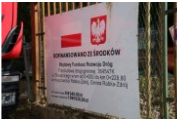
• 2023-08-09-Remont ulicy Słowackiego
