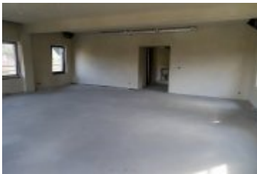
• 2022-11-04-Budowa remizy OSP w Ponicach
