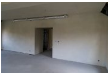
• 2022-11-04-Budowa remizy OSP w Ponicach
