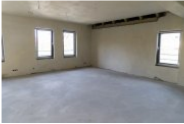
• 2022-11-04-Budowa remizy OSP w Ponicach
