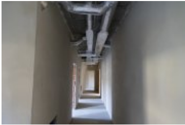
• 2022-11-04-Budowa remizy OSP w Ponicach
