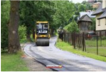
• 2017-06-30-Nowa nawierzchnia na Alei Tysiąclecia
