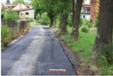
• 2017-06-30-Nowa nawierzchnia na Alei Tysiąclecia
