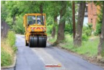
• 2017-06-30-Nowa nawierzchnia na Alei Tysiąclecia
