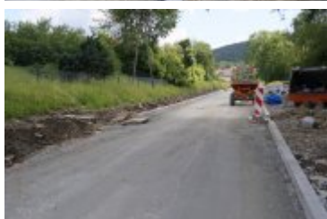
2023-06-29-Remont ulicy Poniatowskiego
