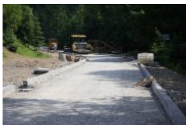
2023-06-29-Remont ulicy Poniatowskiego
