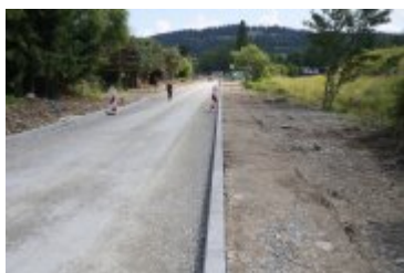
2023-06-29-Remont ulicy Poniatowskiego
