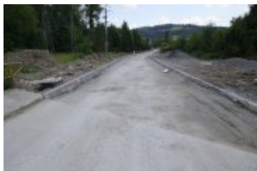
2023-06-29-Remont ulicy Poniatowskiego
