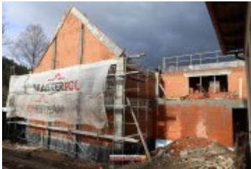
• 2017-02-24-Budowa sali gimnastycznej w Ponicach
